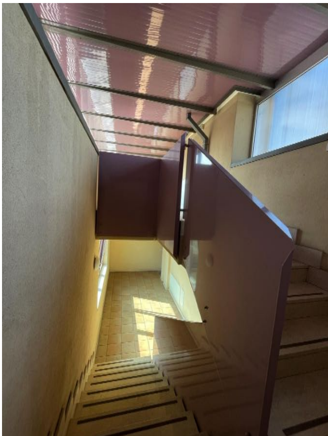
Vano scale comune
