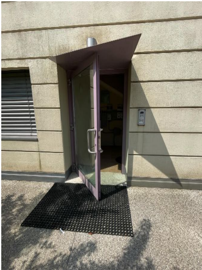
Ingresso comune (piano terra)
