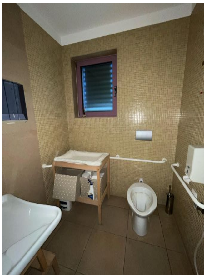
Bagno (piano terra)
